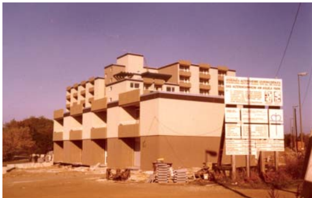
Das Seniorenwohnhaus kurz vor der Fertigstellung 1976
